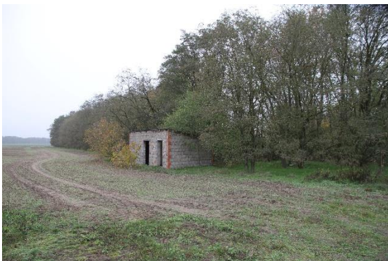
Nördliche Grenze des Ackerlandes mit baulicher Anlage
