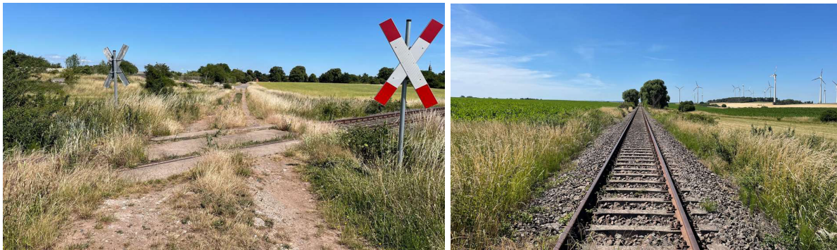
Abb. 2: Bahntrasse der Güterverkehrstrecke Haldensleben-Weferlingen. Links Bahnübergang mit Blickrichtung: Behnsdorf / Osten; Rechts: Blickrichtung: Nordwest.
