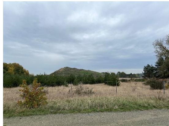
Östlich angrenzendes Flurstück mit bereits bestehender PV-Anlage
